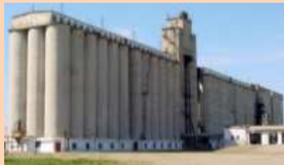
Наличие 1 элеватора с железнодорожным тупиком
