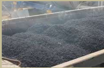
Производство асфальтобетонных смесей – 14 855 тонн
